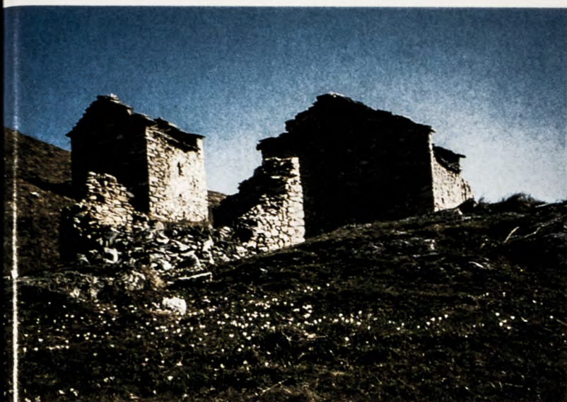
Qui accanto: Stalle La Penna, ove è evidente la struttura a "tetto racchiuso", protetto dai muretti laterali.
