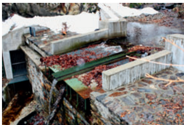
Pietrisco e fogliame (freccia) intasano le canaline by pass apposte per il DMV su griglia a captazione totale.
