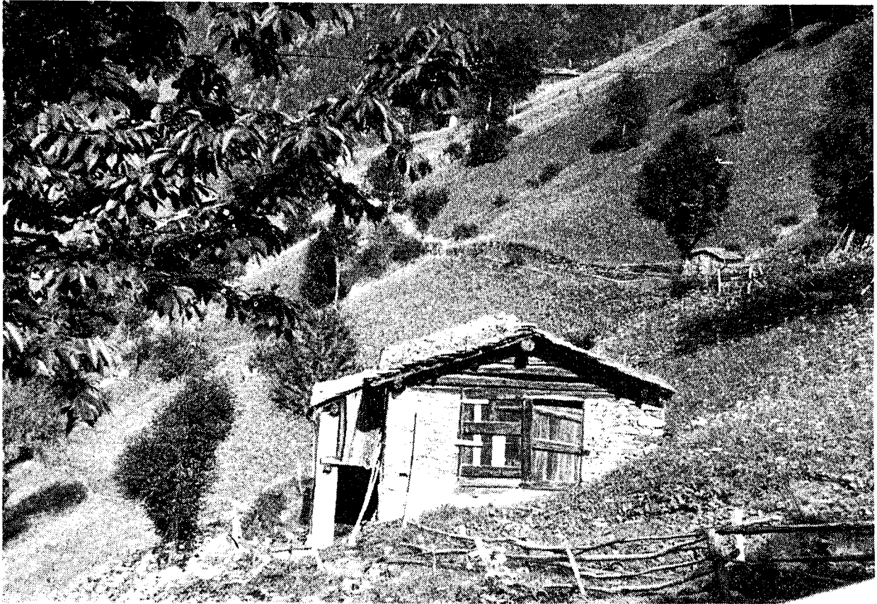
Fig. 16 - Stalla-fienile (masùn), parte in muratura, parte in legno; da notare il piccolo portico, con la sporgenza del tetto, a sinistra, che serve a riparare lo strame.
