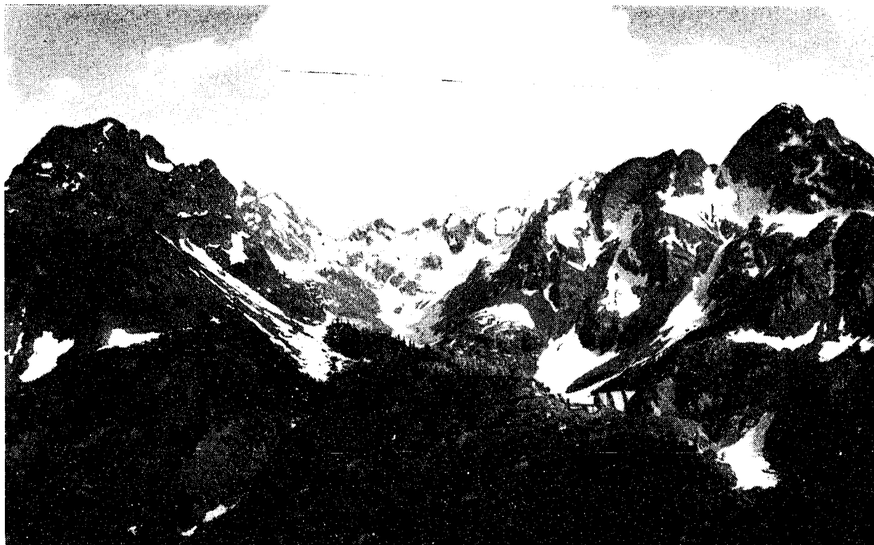
Fig. 10 - La testata della Val Gerola dalla diga (in costruzione) del Lago di Trona allo spartiacque orobico.
