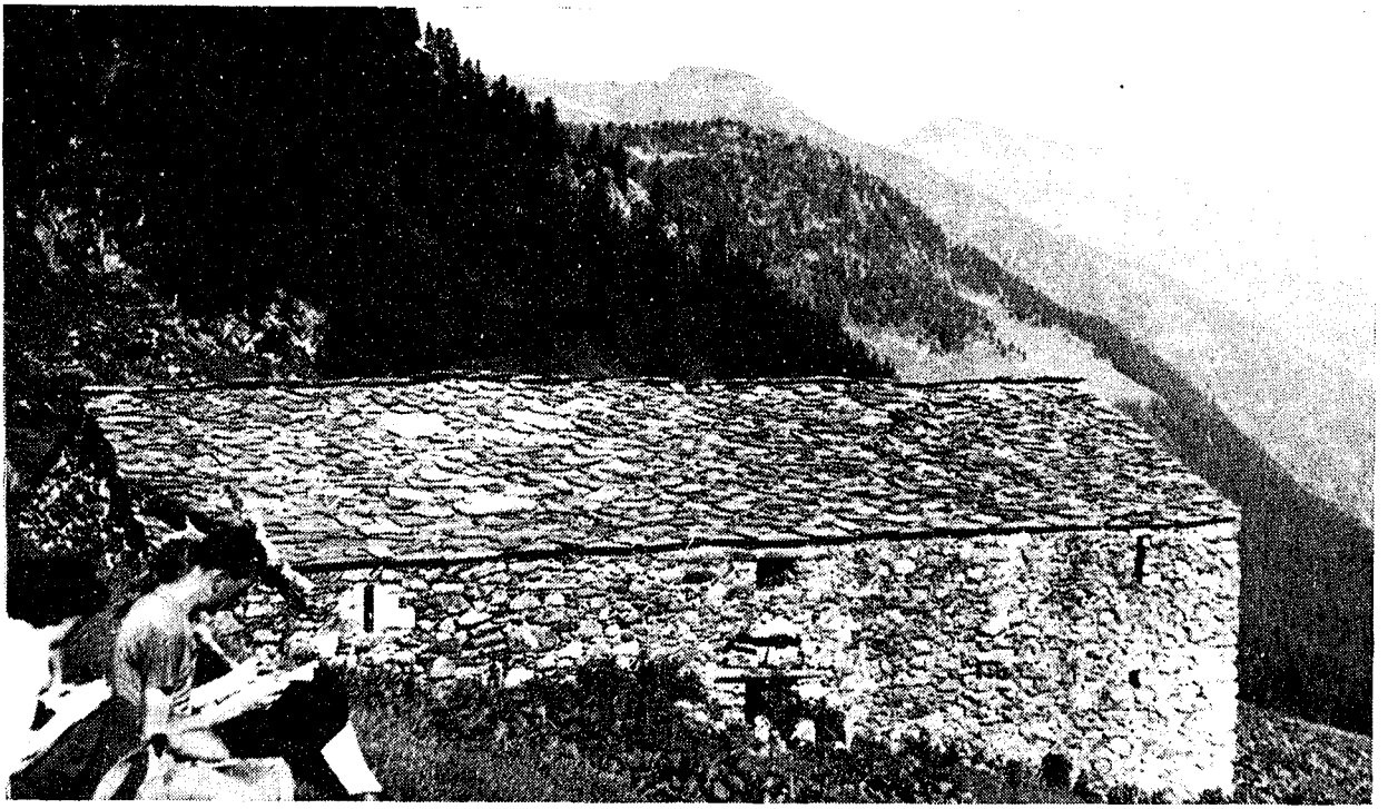
Fig. 26 - Casera Pescegallo (m 1595) per deposito formaggi e altri latticini. Tetto coperto di piöde locali.
