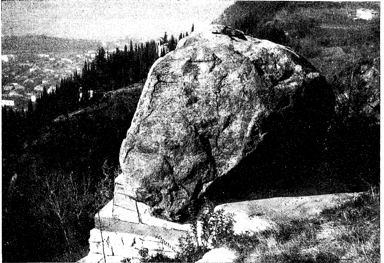
Fig. 5 - L'imponente erratico di Fontane Zurane sopra Provaglio d'Iseo, sostenuto da un manufatto in cemento per impedirne la caduta. (Foto Záina)
